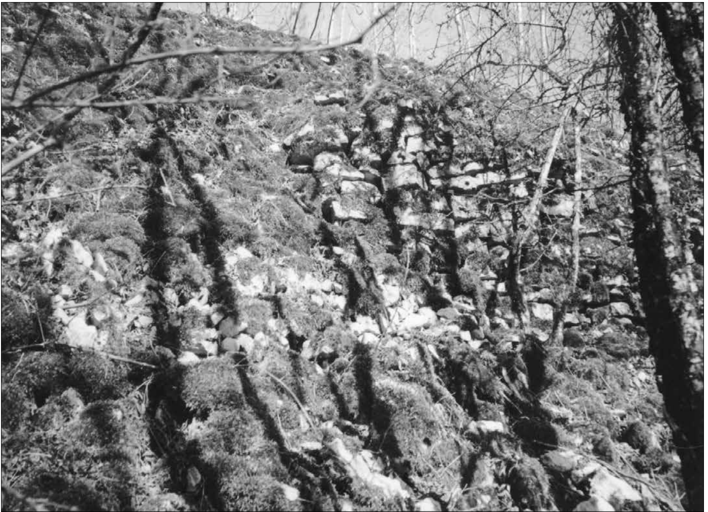
Abb. 2: Heute präsentieren sich die ehemaligen „Keltenmauern“ häufig nur noch als verrutschte, mächtige Steinwälle, denen man nur stellenweise ansieht, dass sie einst gemauert waren. Die eher handlichen Mauersteine sprechen für eine Entstehung nach der Sintflut, die immense Terrassierung für eine Warmzeit, der stark zerstörte Zustand für Katastropheneinwirkungen.
